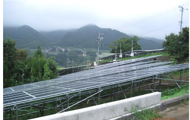
富浜町鳥沢地内坂尻地区・住宅の裏斜面
